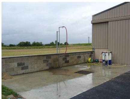
Sur une aire recouverte d'un matériau étanche et résistant mécaniquement et chimiquement en vue d'empêcher toute infiltration de PPP dans le sol
