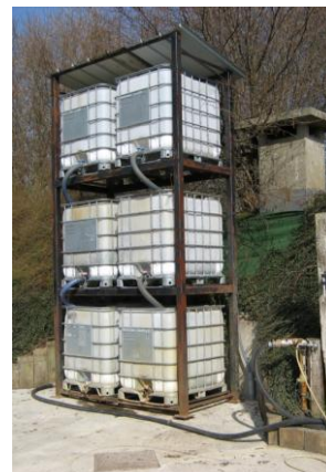
Exemple d'installation de traitement Le biofiltre
